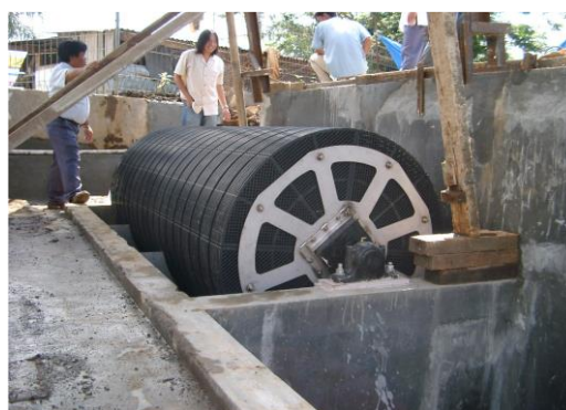
立体格子状接触体を用いた回転円板
