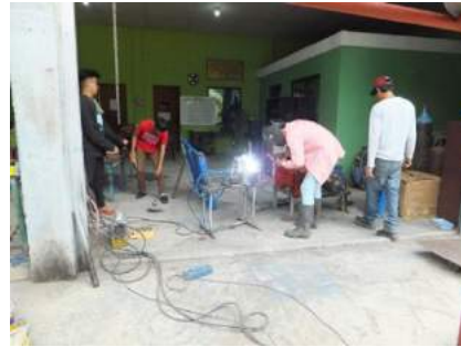
小規模水力発電用の水門の溶接作業
