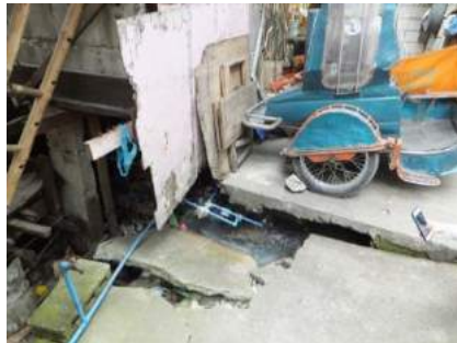
Cruz Compound 内路地の行き止まり部分
